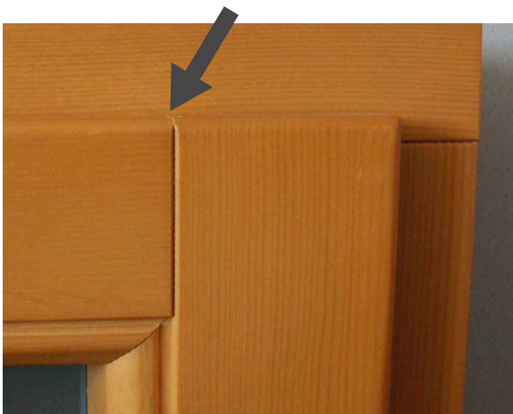
Originalzustand Holzfeuchte bei 13 %
